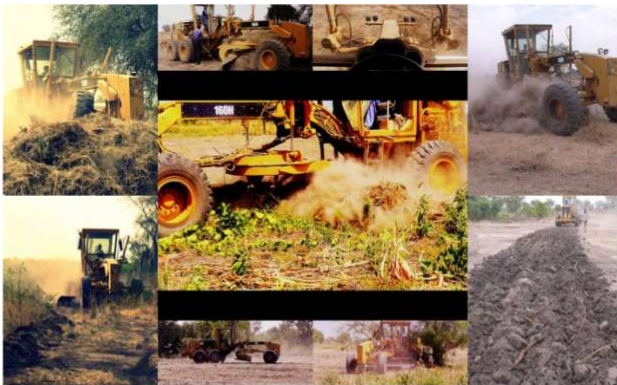
Fot 3: Operacja wyrównania terenu za pomocą gradera
