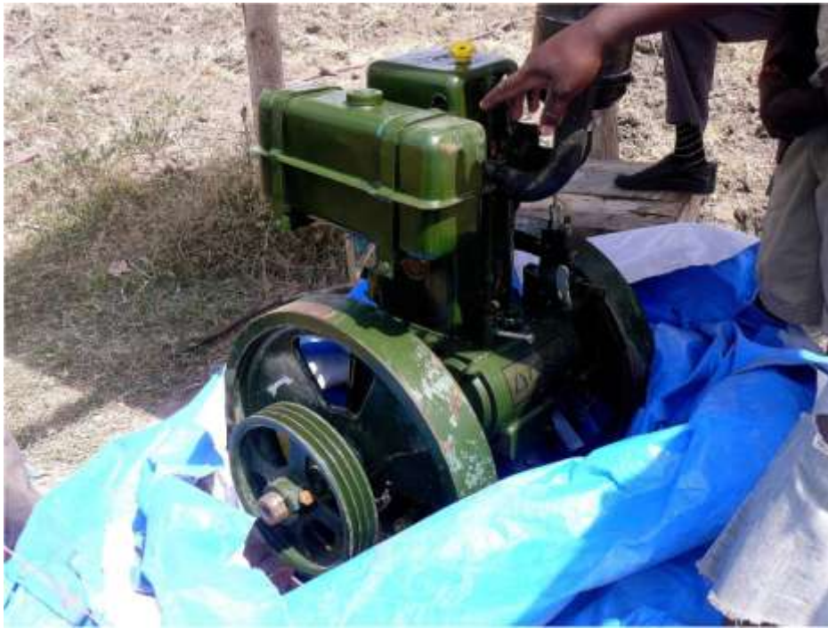
Fot 8: Pompa z generatorem
